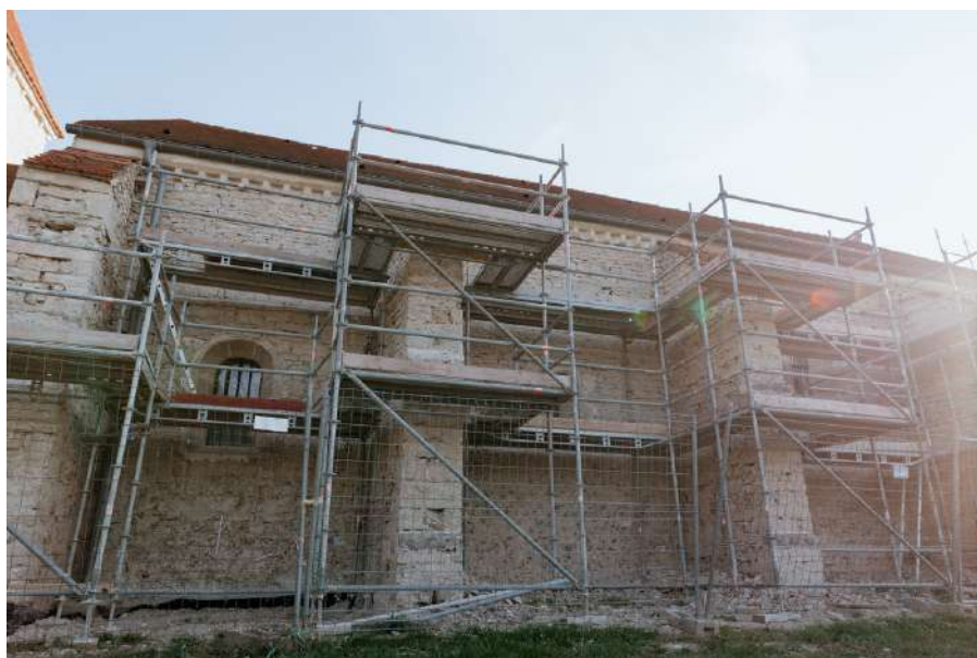
Façade nord piochage et remplacement des pierres gelées
