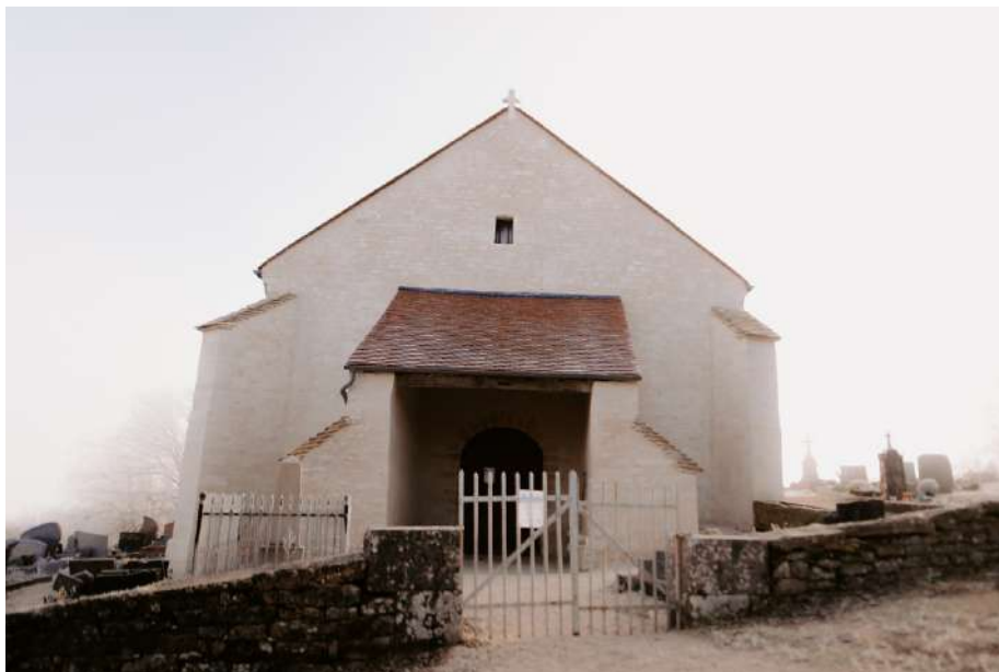
Façade ouest après travaux
