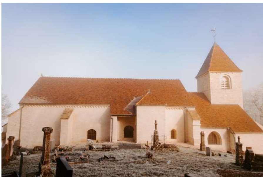
Crédit photos : Amandine Dirand Façade sud après travaux
