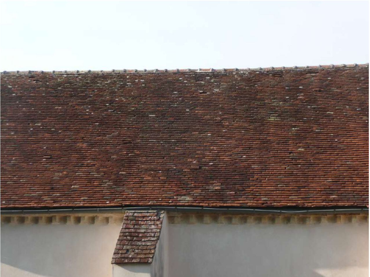
Crédit photo : Laurent Bedenne Toiture et contre-fort avant travaux
