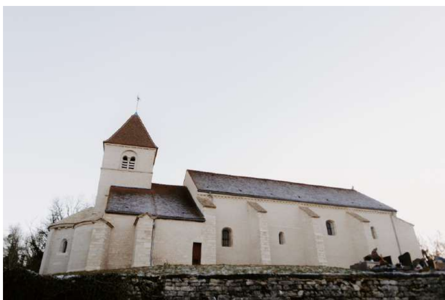
Façade nord après travaux
