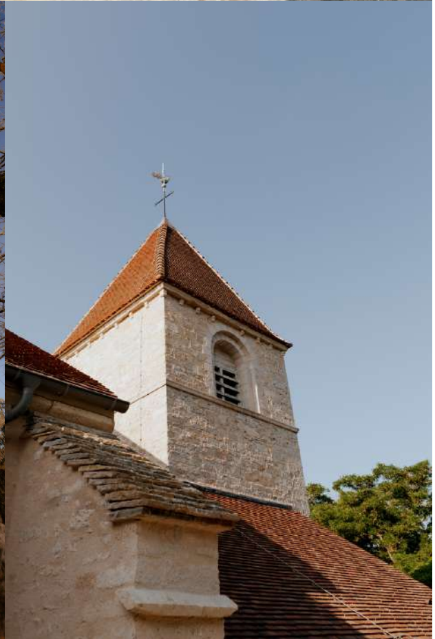
Crédit photo : Amandine Dirand Cloche et absidioles r après travaux
