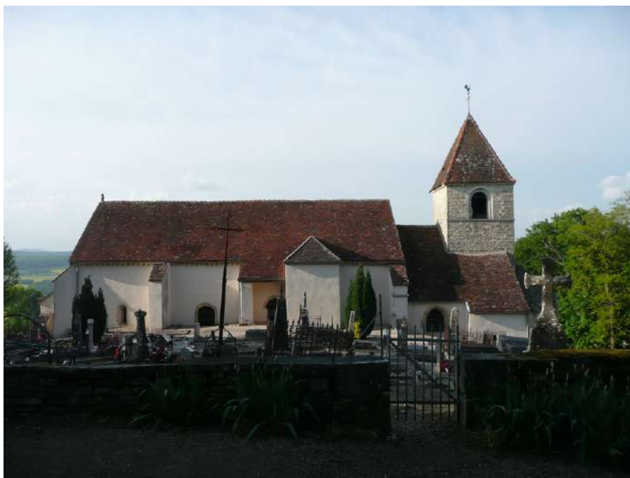
Crédit photo : Laurent Bedenne Façade sud avant travaux
